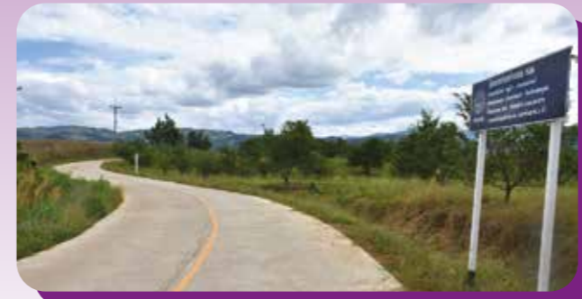
โครงการก่อสร้างถนน คสล. สายบ้านห้วยโป่งน้ำ หมู่ที่ 9 ตำบลตาตกลอย อำเภอหล่มเก่า จังหวัดเพชรบูรณ์
