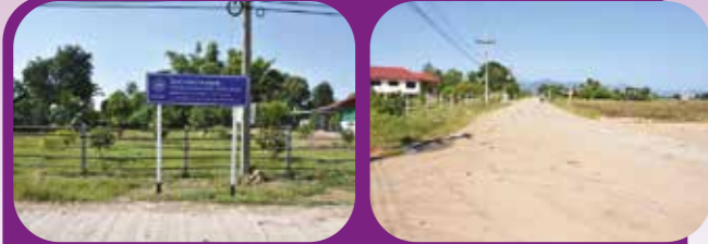
โครงการก่อสร้างถนน คสล. บ้านใหม่สามัคคี หนองโสน หมู่ที่ 4 ตำบลห้วยโป่ง อำเภอหนองไผ่ จังหวัดเพชรบูรณ์
