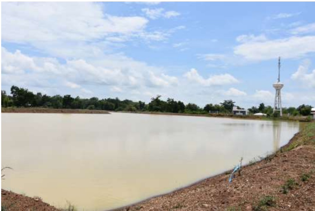
โครงการขุดลอกสระเก็บน้ำ บ้านศรีมงคล หมู่ที่ ๑ ตำบลศรีมงคล อำเภอบึงสามพัน จังหวัดเพชรบูรณ์
