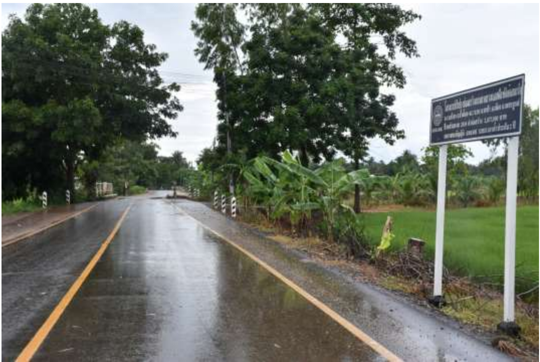
โครงการปรับปรุงซ่อมสร้างถนนถนนลาดยาง แอสฟัลท์คอนกรีต หมู่ที่ ๘ บ้านหัวนา ตำบลบ้านโตก - หมู่ที่ ๒ บ้านบง ตำบลนาป่า อำเภอเมือง จังหวัดเพชรบูรณ์
