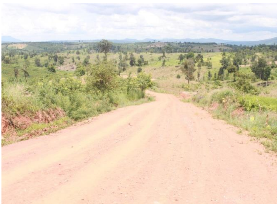
ก่อสร้างถนนฝิวจราจรวัดคัดเลือก บ้านห้วยหญาเครือ หมู่ที่ ๑ ตำบลน้ำหนาว อำเภอน้ำหนาว จังหวัดเพชรบูรณ์
