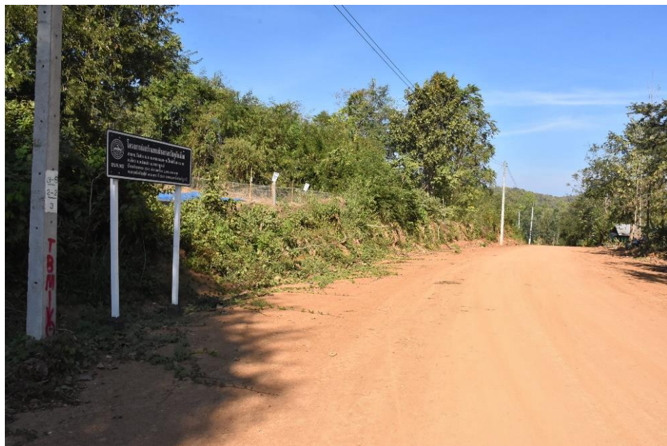
โครงการก่อสร้างถนนผิวจราจรวัสดุคัดเลือก บ้านวังม่วงหมู่ที่ ๘ ตำบลตาคลกต.กอยเชื่อมบ้านใหม่ห้วยนา หมู่ที่ ๑๕ ตำบลบลา อำเภอหล่มเก่า จังหวัดเพชรบูรณ์
